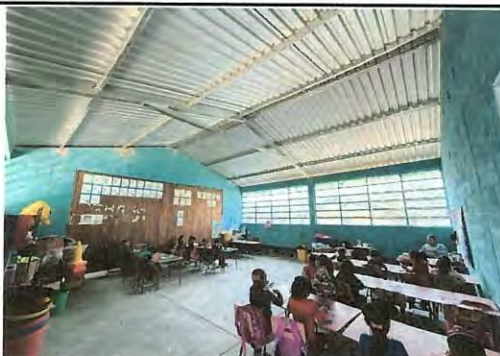
Foto 11: SUSTITUCIÓN E INSTALACIÓN DE CABLEADO ELÉCTRICO, TOMACORRIENTES, INTERRUPTORES, FLIPONES, PLAFONERAS, LAMPARAS Y DUCTO ELECTRICO Y ACCESORIOS
