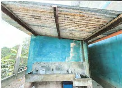
Foto 1: REMOZAMIENTO AREA DE SANITARIOS
