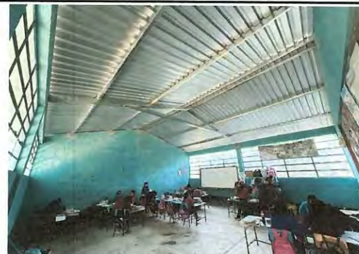
Foto 10: SUSTITUCIÓN E INSTALACIÓN DE CABLEADO ELÉCTRICO, TOMACORRIENTES, INTERRUPTORES, FLIPONES, PLAFONERAS, LAMPARAS Y DUCTO ELECTRICO Y ACCESORIOS
