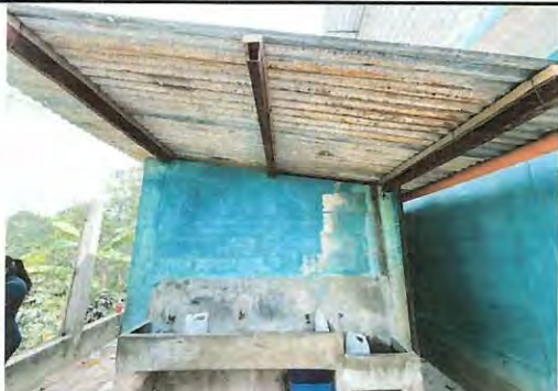
Foto 3: INSTALACIÓN DE PISO CERÁMICO EN ÁREA DE SANITARIOS Y MEJORAMIENTO DE ESTRUCTURA DE TECHO E INSTALACIÓN DE LÁMINAS TROQUELADA CALIBRE 26
