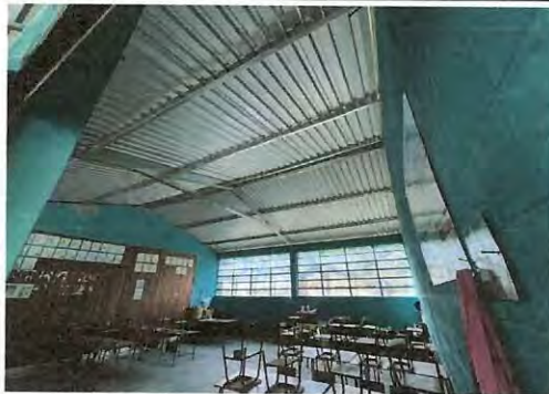
Foto 9: PINTURA EN MUROS EXTERIORES E INTERIORES DE DOS EDIFICIOS ESCOLARES
