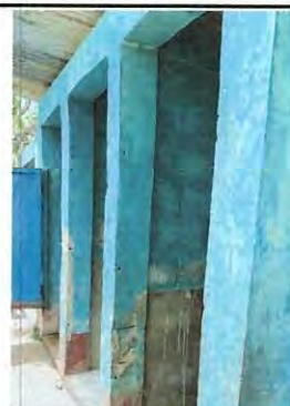
Foto 4: SELLADO DE GRIETAS Y FISURAS, SERNIDO Y REPELLO EN MUROS Y FABRICACIÓN E INSTALACIÓN DE PUERTAS DE METAL EN BAÑOS
