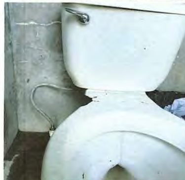
Foto 2: SUSTITUCIÓN DE INODOROS DAÑADOS
